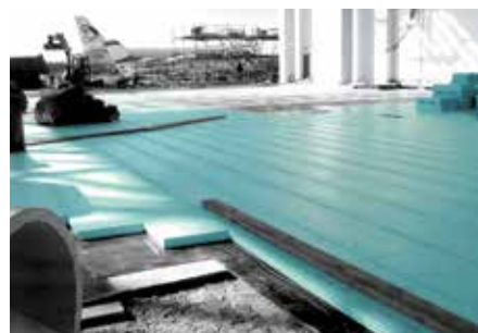
Tepelná ochrana podlahy v hangáru pomocí FIBRANxps 700-L.
