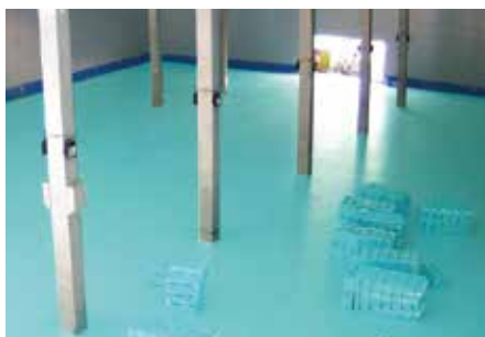
Tepelná izolace podlahy chladírny pomocí FIBRANxps 500-L, 700-L.
